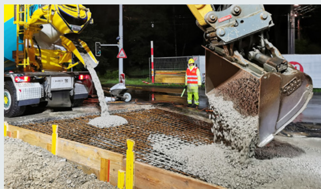
Hirschwiesentunnel Zürich Decke mit Concretum® Q-FLASH 2/20
