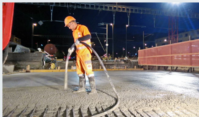
Unterführung Bahnhof Zofingen Deckel Unterführung mit Q-FLASH 2/20
