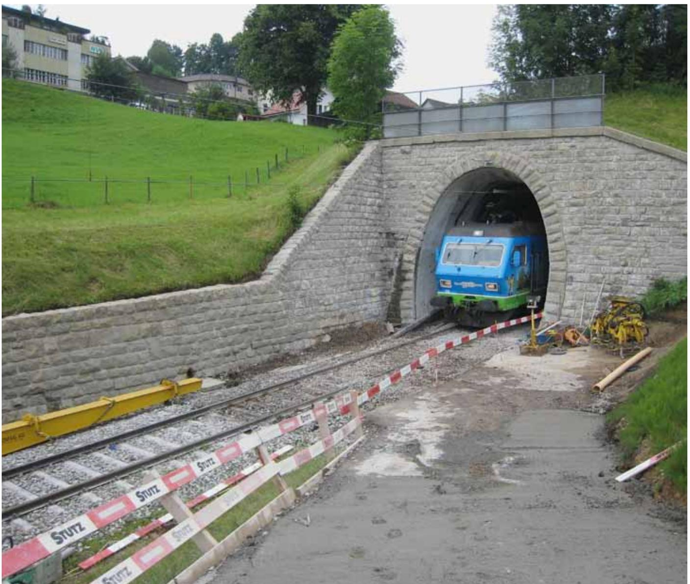
Bahnverbindung Herisau–St. Gallen. Der 110 Jahre alte Tunnel besteht aus einem gemauerten Gewölbe und einer Sohle aus Beton. Bei diesem typischen Vertreter für viele Tunnels im Alpenraum mussten unter anderem diverse Schäden und Mängel an der Sohle saniert und die Gleisachse um gut 20 cm abgesenkt werden.
