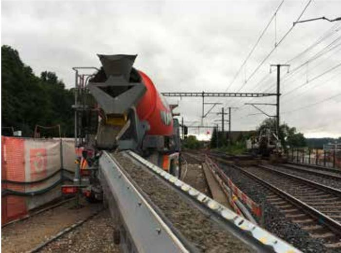
Ein Förderband transportiert den Beton vom Fahrmischer zum Bauteil.
