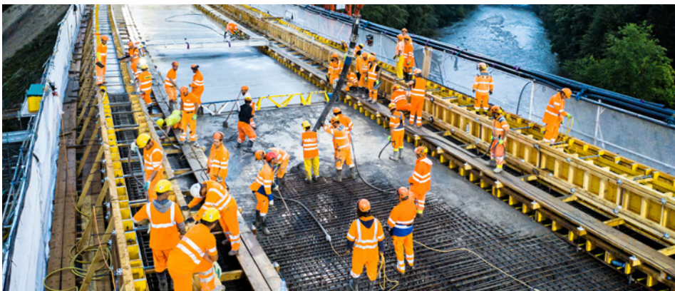
Betonierung von Brückentrog und Bordüre 570 m³
