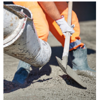
Pumpbeton für Brückentrog
