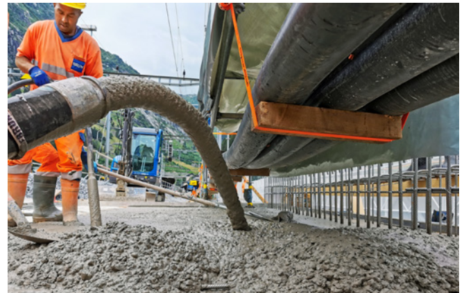
Einbau Pumpbeton
