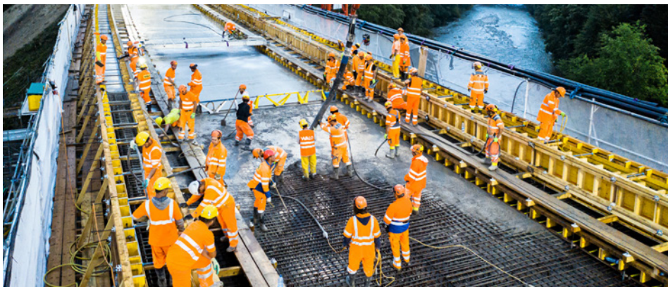
Betonierung von Brückentrog und Bordüre 570 m³
