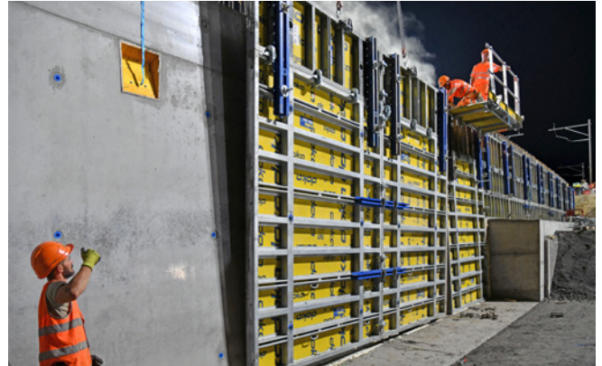
Stützmauer: Ausschalen 6 h nach Betonieren
