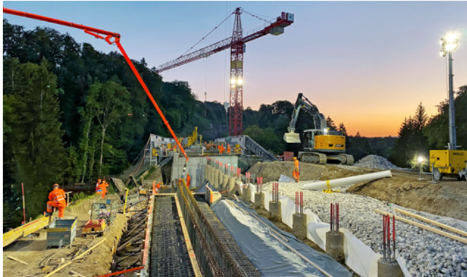
Die Pfähle (25 m³) werden bereits genutzt, während die Stützmauer für das Betonieren vorbereitet wird.
